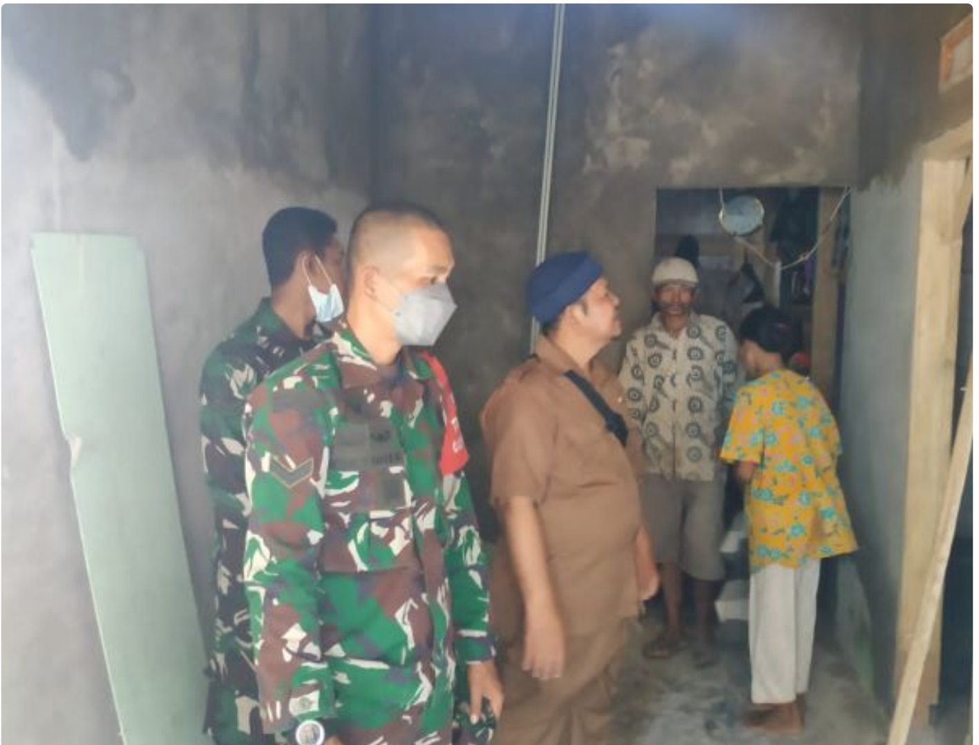
Warga Desa Cikahuripan Dapat Bantuan Rehab Rumah, Anggota Koramil 0622-01/Cisolok Kontrol Pembangunannya
